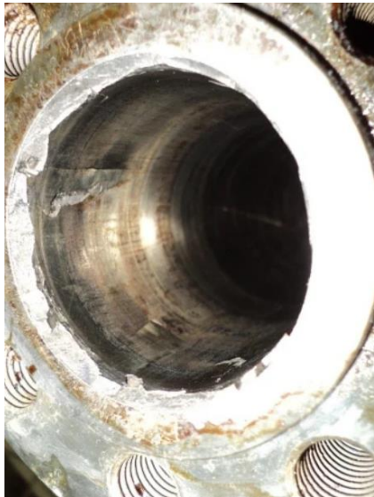
Uszkodzona warstwa bimetalu cylindra
